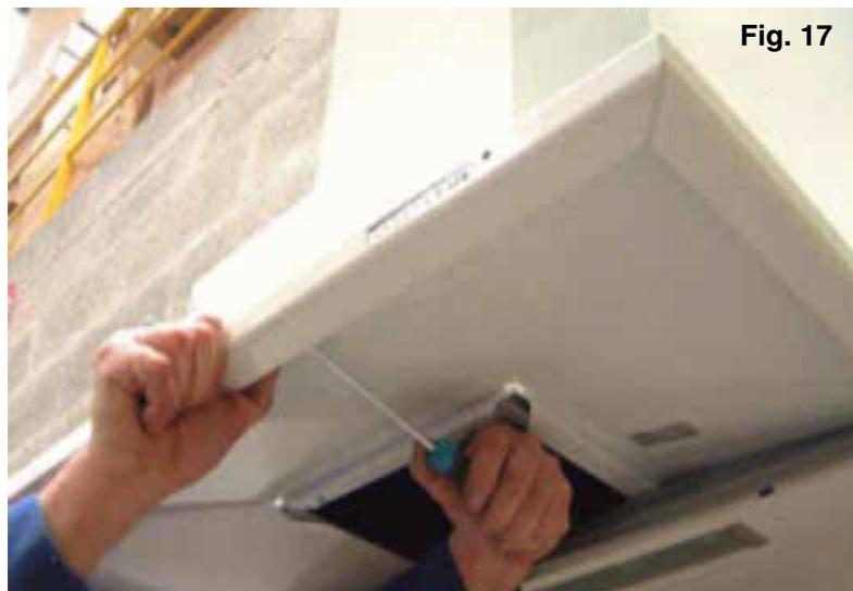
Colocar de nuevo la caja de control en la apertura del listón frontal de aluminio.
