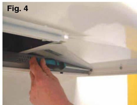
Suelte los dos 3 tornillos de cada uno del lado izquierdo y del derecho de la campana extractora de humos (fig. 5).
