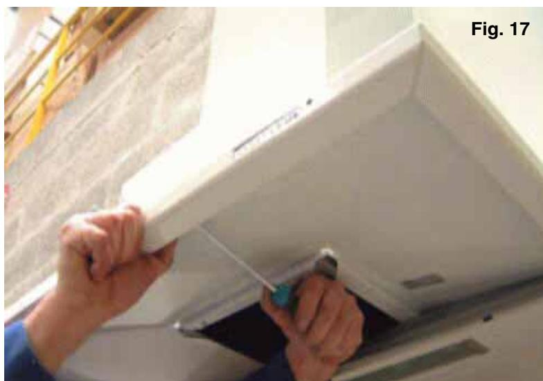
Replacer le bloc de commande dans l'ouverture du bandeau frontal en aluminium.
