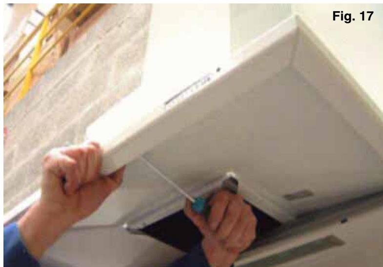
Installare di nuovo il blocco di comando nell'apertura del pannello anteriore di alluminio.
