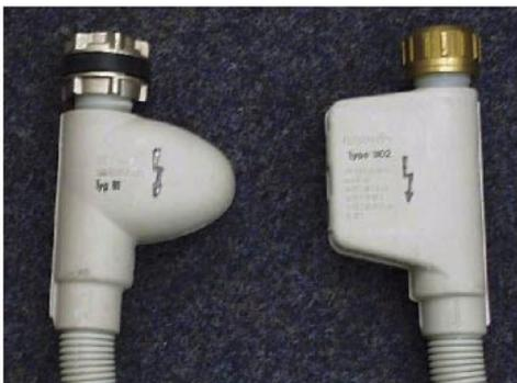
*Izquierda:* Tubo de parada de agua (Aqua-Stop) con una válvula;
