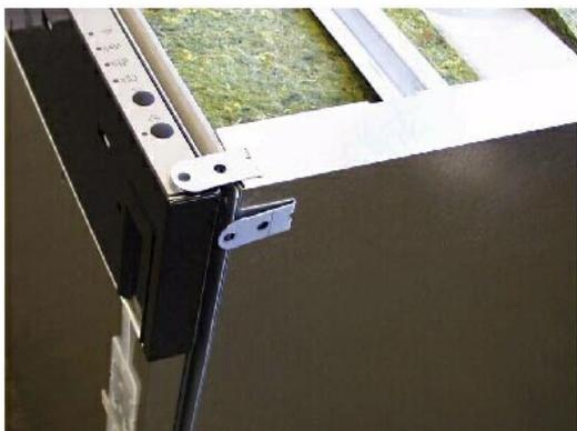
La fijación del lavavajillas tiene lugar por medio de dos piezas de unión o bien directamente a la superficie de trabajo o al armario contiguo.
