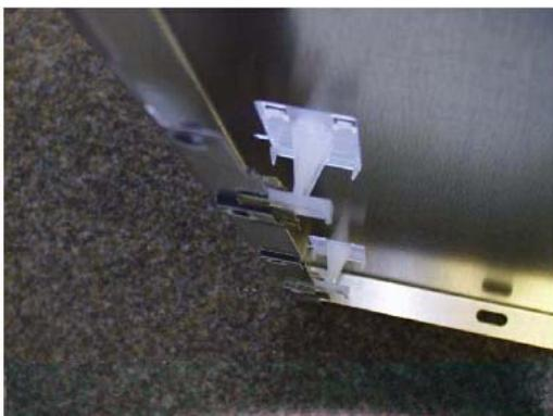
Principe de fixation des attaches en plastique :
