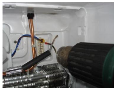
6. Bei den Verdampfersensoren müssen Sie alle Teile mit Heißluft einschrumpfen.
