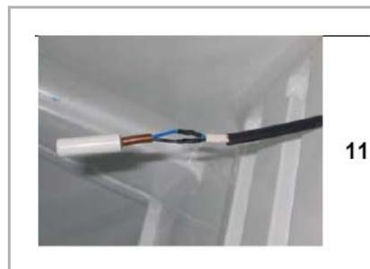
12. Chauffer la gaine thermorétractable de 50 mm pour isoler les câbles avec les joints.
