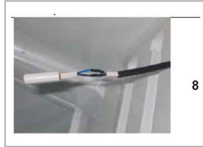
9. Chauffer la gaine thermorétractable de 50 mm pour isoler les câbles avec les joints.
