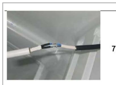
8. Chauffer les 2 gaines thermorétractables pour isoler les 2 joints étamés.
