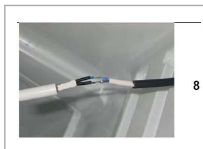
9. Chauffer les 2 gaines thermorétractables pour isoler les 2 joints étamés.
