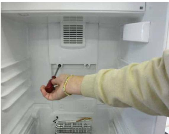
1. Allentare le due viti di fissaggio dell'alloggiamento del ventilatore ed estrarre l'alloggiamento tirandolo verso il basso.
