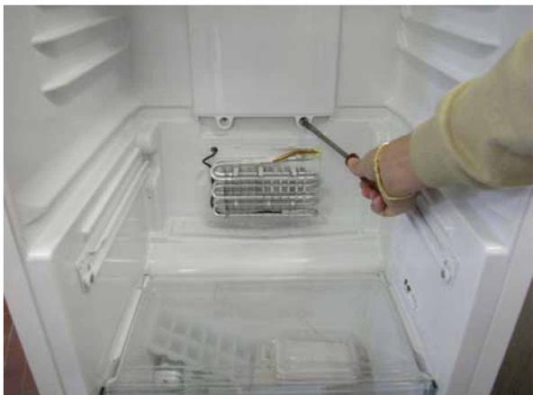
1. Desapertar os dois parafusos de fixação do canal (ou canal com filtro, se existir); para remover, puxar o canal para baixo.
