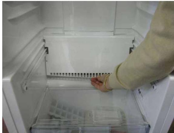
4. Desapertar os dois parafusos de fixação da cobertura do vaporizador.
