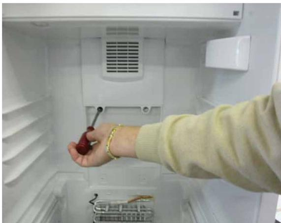
1. Desapertar os dois parafusos de fixação da caixa do ventilador e puxar para baixo a caixa.
