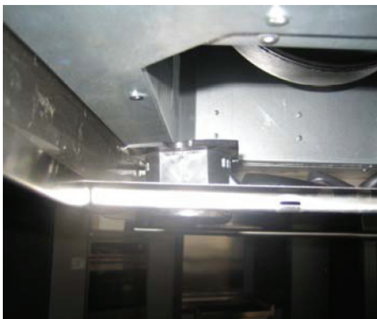
Bild 3 Nach dem Einbau
