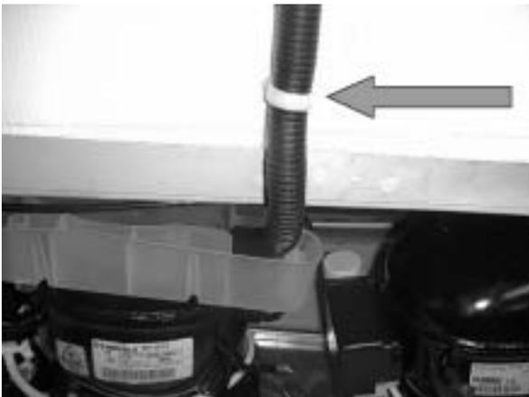
Den unteren Teil des Abtauwasserschlauchs mit einer Befestigungsklemme befestigen und sicherstellen, dass der Schlauch sich richtig im Wasserbehälter befindet.
