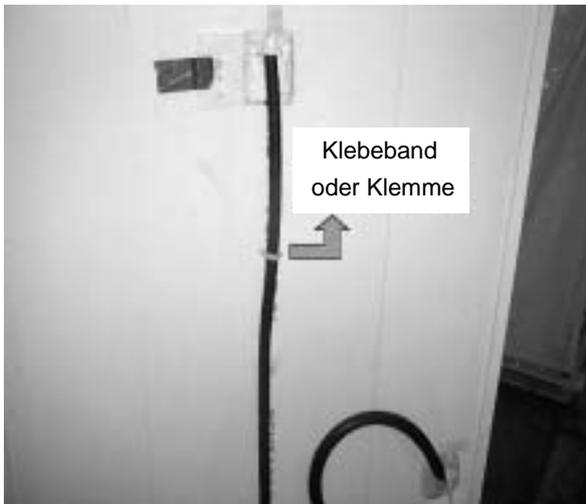
Den schwarzen Abtauwasserschlauch (Elektroschlauch) in den weißen Abtauwasserstutzen stecken und mit Klebeband oder einer Kunststoffklemme an der Rückwand befestigen.
