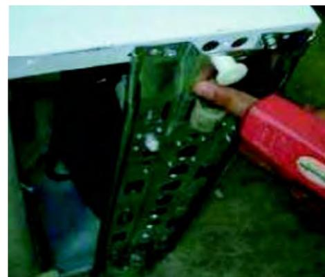
4. Stellen Sie sicher, dass die Gewindehülse bis zum Anschlag fest eingeschlagen ist.
