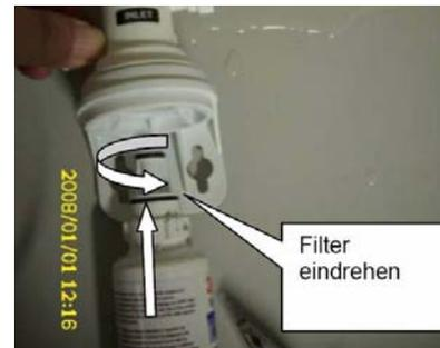
Darauf achten, dass der Wassereingang und der Wasserausgang berücksichtigt werden!
