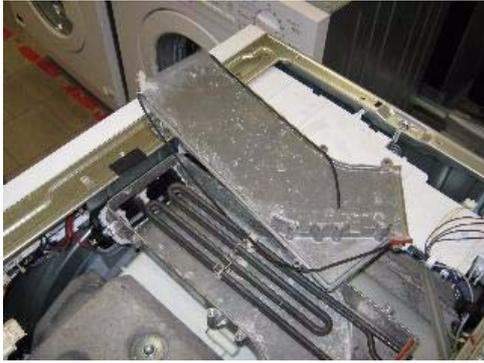
4. Die beiden Befestigungsschrauben des Heizelements lösen.
