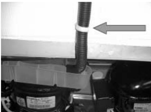
Fixer la partie inférieure du tuyau eau de dégivrage à l'aide d'une pince de fixation et s'assurer que le tuyau est bien placé dans le réservoir d'eau.
