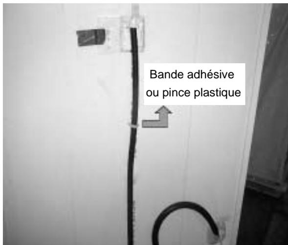
Glisser le tuyau noir eau de dégivrage (tuyau parcouru par le courant) dans l'embout blanc eau de dégivrage et le fixer à l'aide d'une bande adhésive ou d'une pince plastique sur la paroi arrière.
