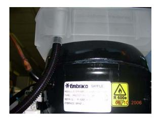
Introduire le tuyau souple d'écoulement dans le bac d'évaporation situé sur le compresseur.
