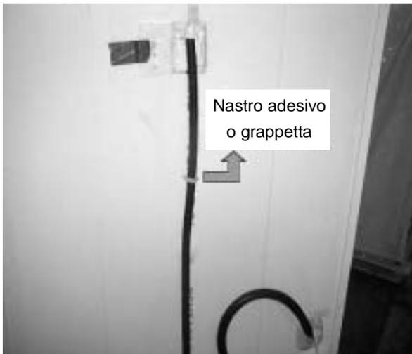
Inserire il tubo nero (tubo elettrico) nel manicotto bianco e fissarlo alla parete posteriore con un nastro adesivo o una grappetta.
