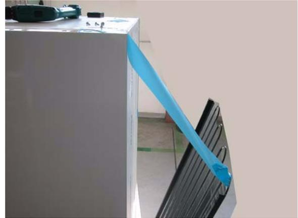
4. Rimuovere le viti di fissaggio del condensatore e fissare quest'ultimo al frigorifero con nastro adesivo.
