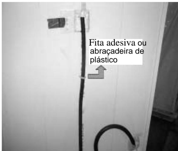
Inserir o tubo preto de água de descongelação (tubo eléctrico) no bocal branco de água de descongelação e fixar com fita adesiva ou uma abraçadeira de plástico na parede traseira.
